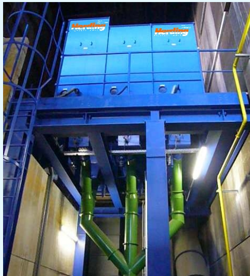
Herding® Filterabsaugung
