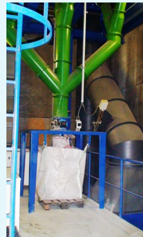
Staubauszug aus der Herding® Filteranlage in ein Big-Bag-System
